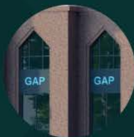
Облицовка фасадов из гранита
