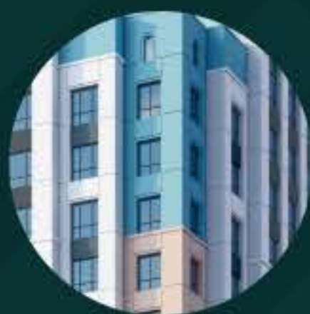
Облицовка из композитных панелей
