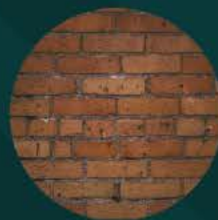
Межквартирная перегородка из кирпича 250 мм
